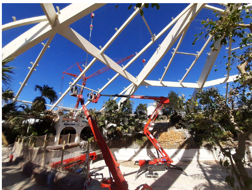
Installation du toit du dôme en polycarbonate
